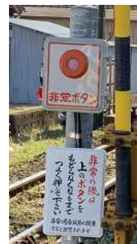
押ボタン式踏切 支障報知装置
