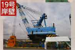
グラブ浚渫船兼起重機船 27金剛
